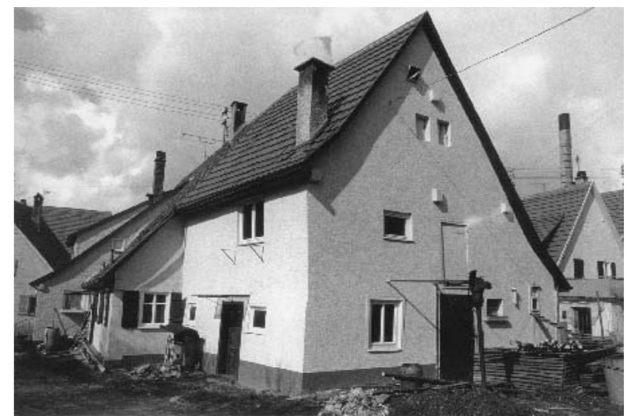
Das Haus Waibachstraße 15 vor der Renovierung in den frühen 80er Jahren des 20. Jahrhunderts. Im Hintergrund die Waibachstraße 13.
