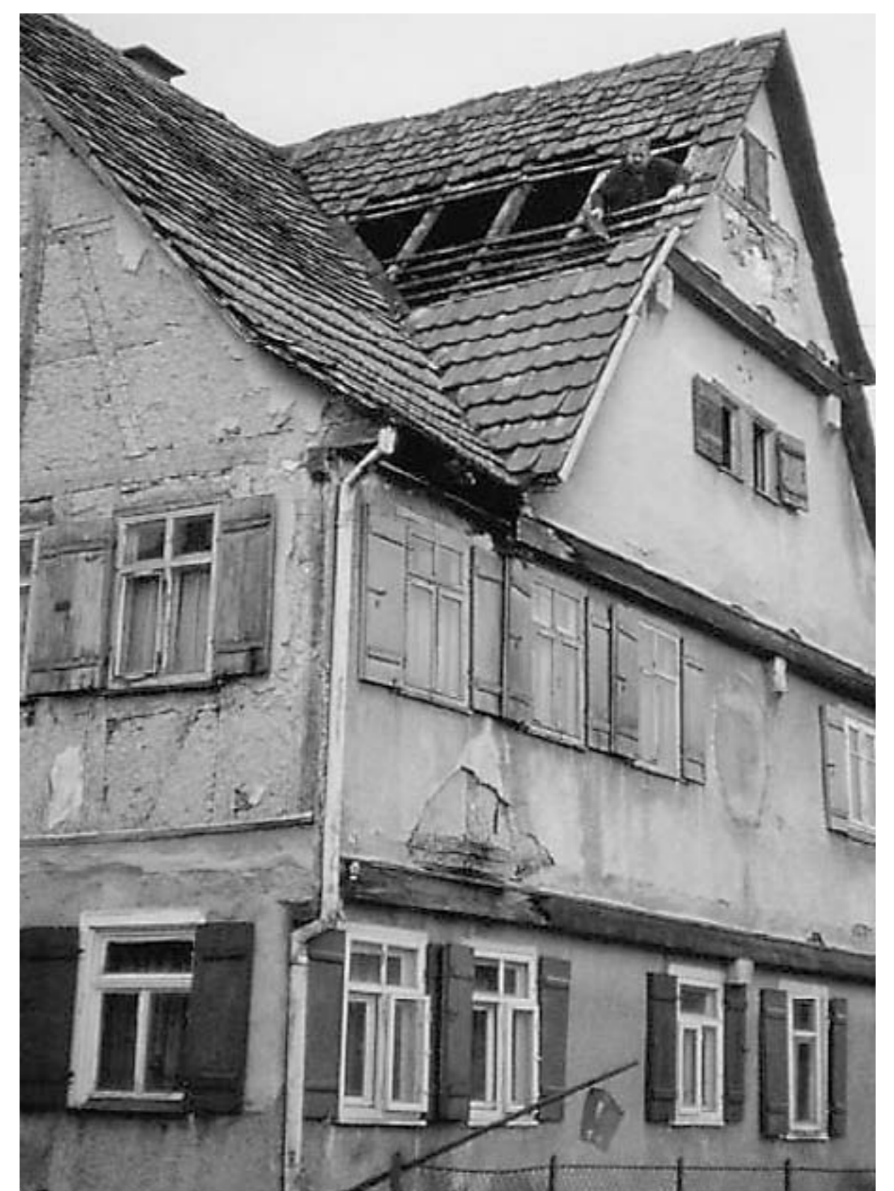
Paul Streib bei Ausbesserungsarbeiten auf dem Dach des Hauses Waibachstraße 26
