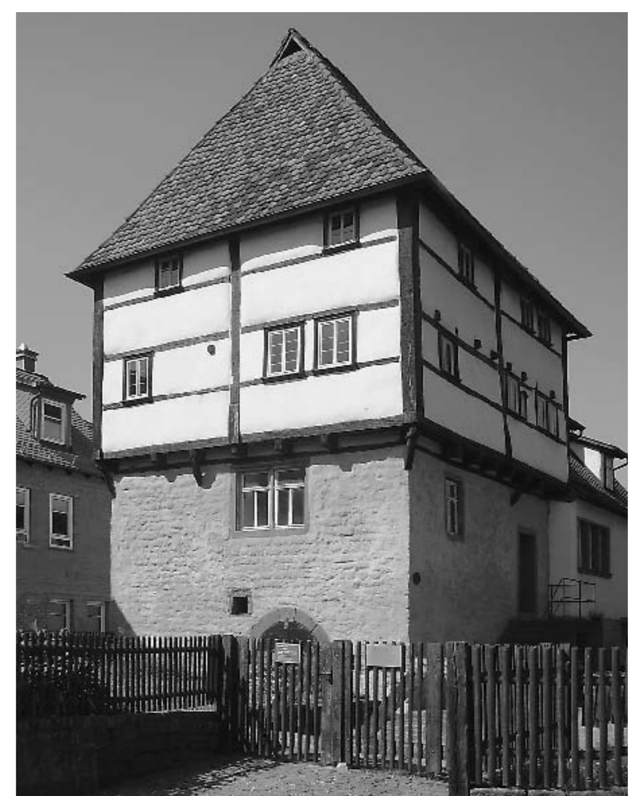
Turmburg Templerhaus in Amorbach, 1291 erbaut
